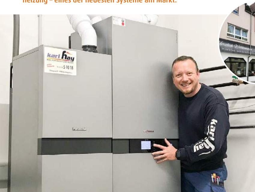
Zimmer an kalten Tagen kuschelig warm, ohne dass viel Erdgas verbraucht wird. Um die Spitzenlast im Winter abzudecken, ist in die Heizung zusätzlich ein 32-kW-Brennwertkessel integriert.
